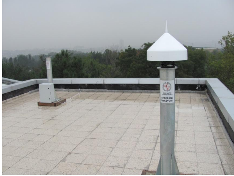
Şekil 1. YLDZ GNSS İstasyonu
