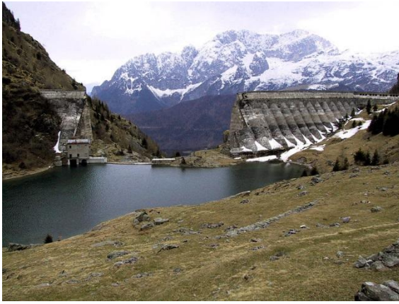
Şekil 1. a) Barajında meydana gelen yıkılma
