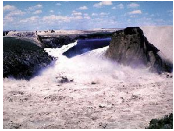
b) Teton Barajında meydana gelen yıkılma
